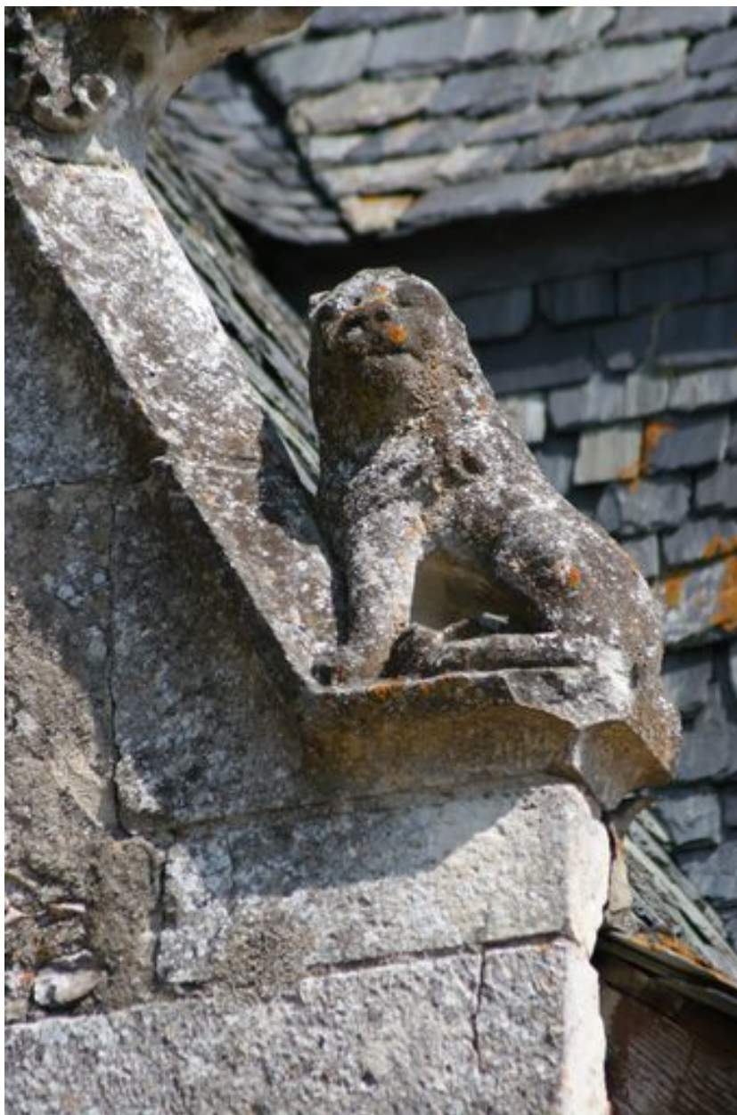
Le logis, pignon sud : rondelis.
