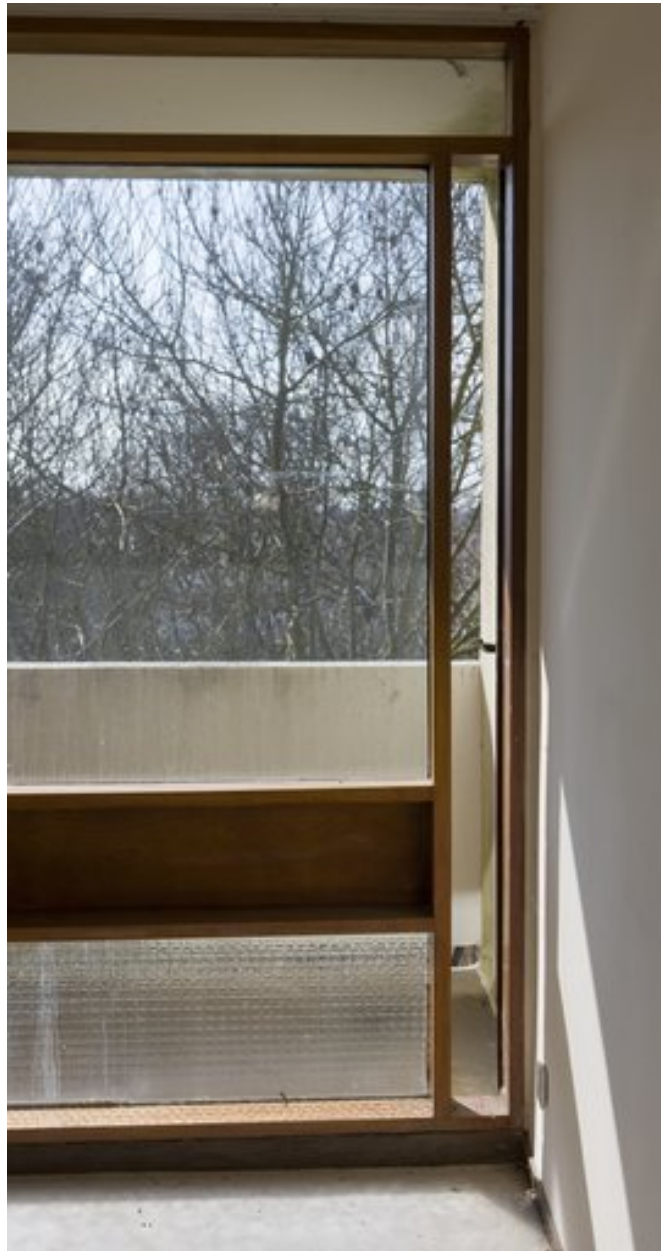
Vue d'une chambre : détail du volet d'aération.
