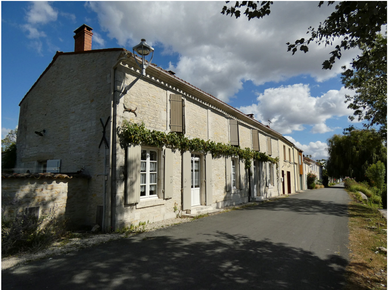
L'ancienne ferme vue depuis l'ouest.
