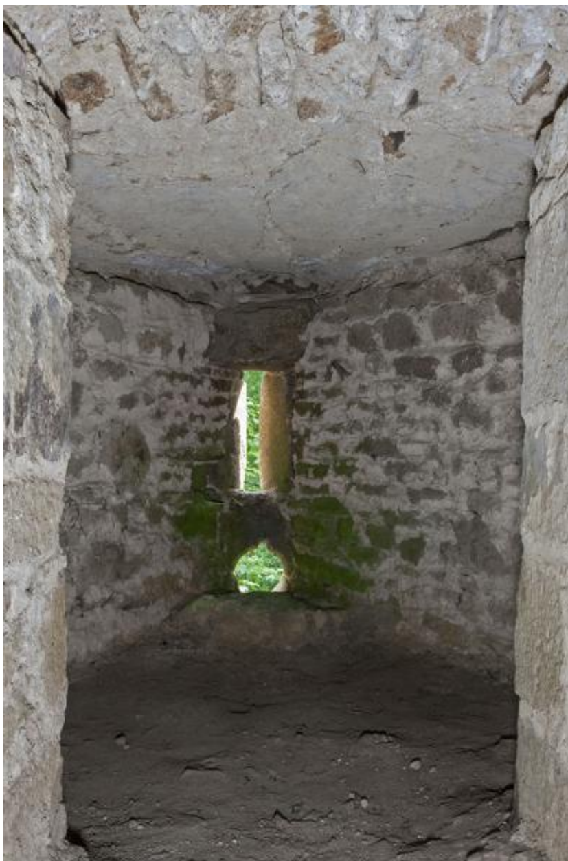
Casemate centrale de la tour Lavoisier, niveau de soubassement.
