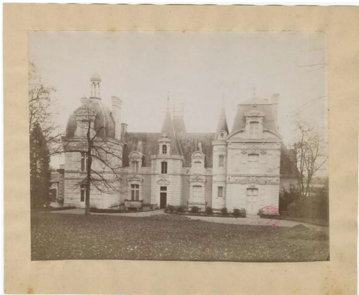
Façade avant du château du Fresne, à la Pointe. Photographie. Fin 19e siècle. (AD Maine-et-Loire ; 11 FI 2966).
