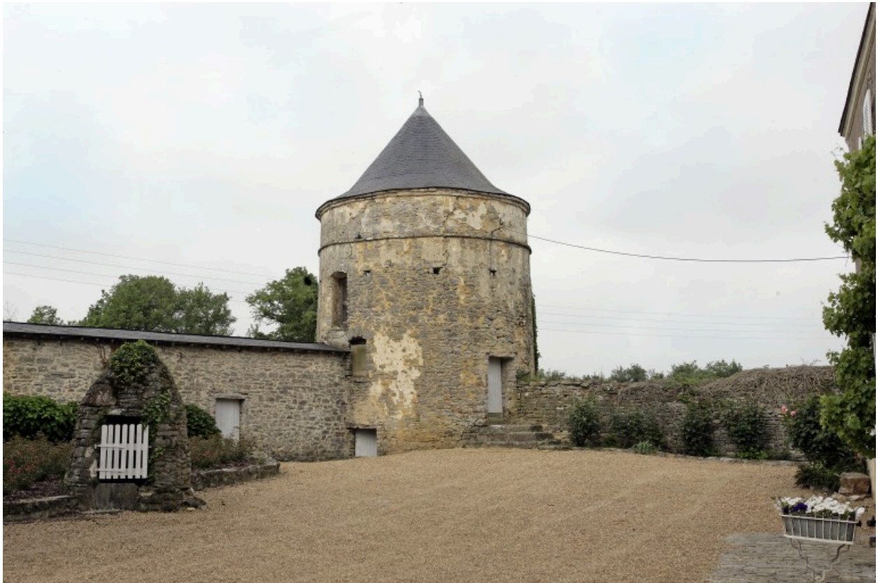
Le puits et le colombier vus depuis le nord-est.
