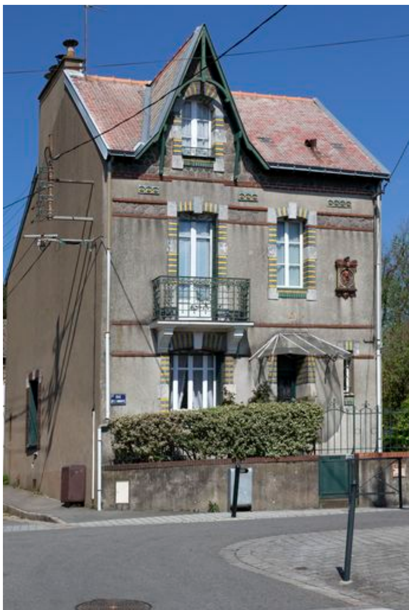
Façade de la maison située au n° 38 rue de l'Abbaye (maison inscrite sur la liste du patrimoine nantais du plan local d'urbanisme).
