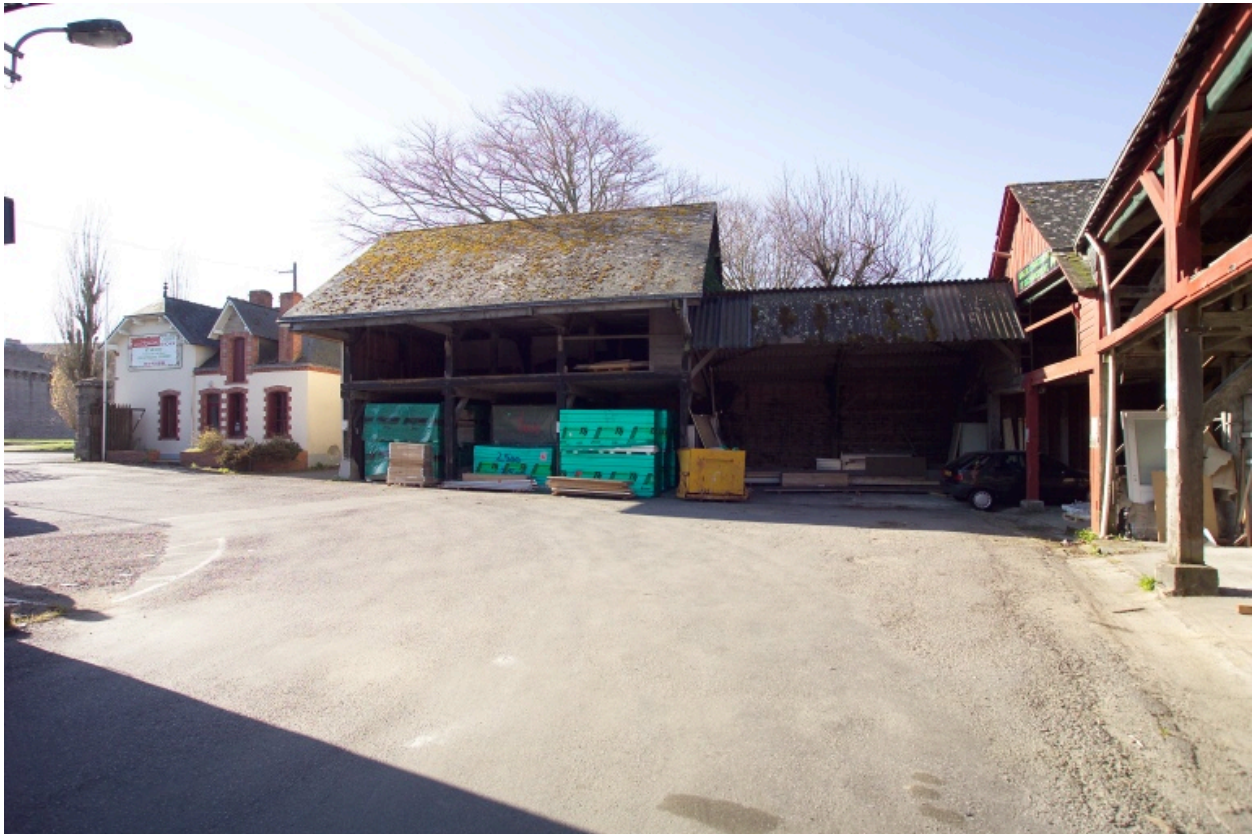
Cour d'entrée, vue des hangars et du bureau.
