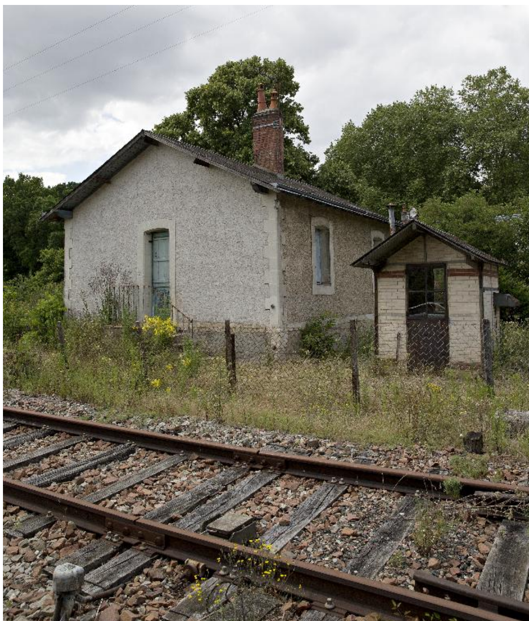
Poncé-sur-le-Loir, Paillard : maison de garde-barrière et cabirotte, PN 114.
