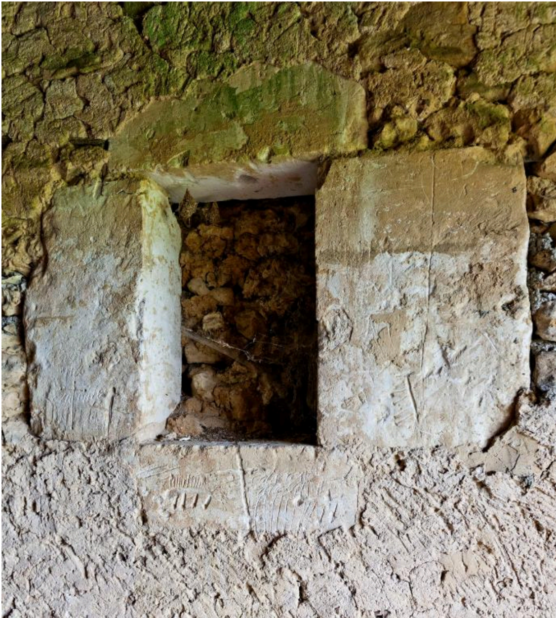
Ferme 1, maison, mur extérieur nord : baie obturée.
