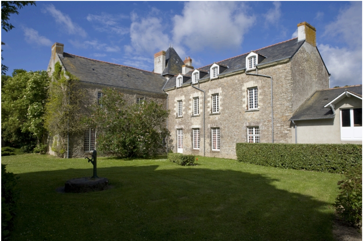
Logis. Vue d'ensemble depuis le nord-est.
