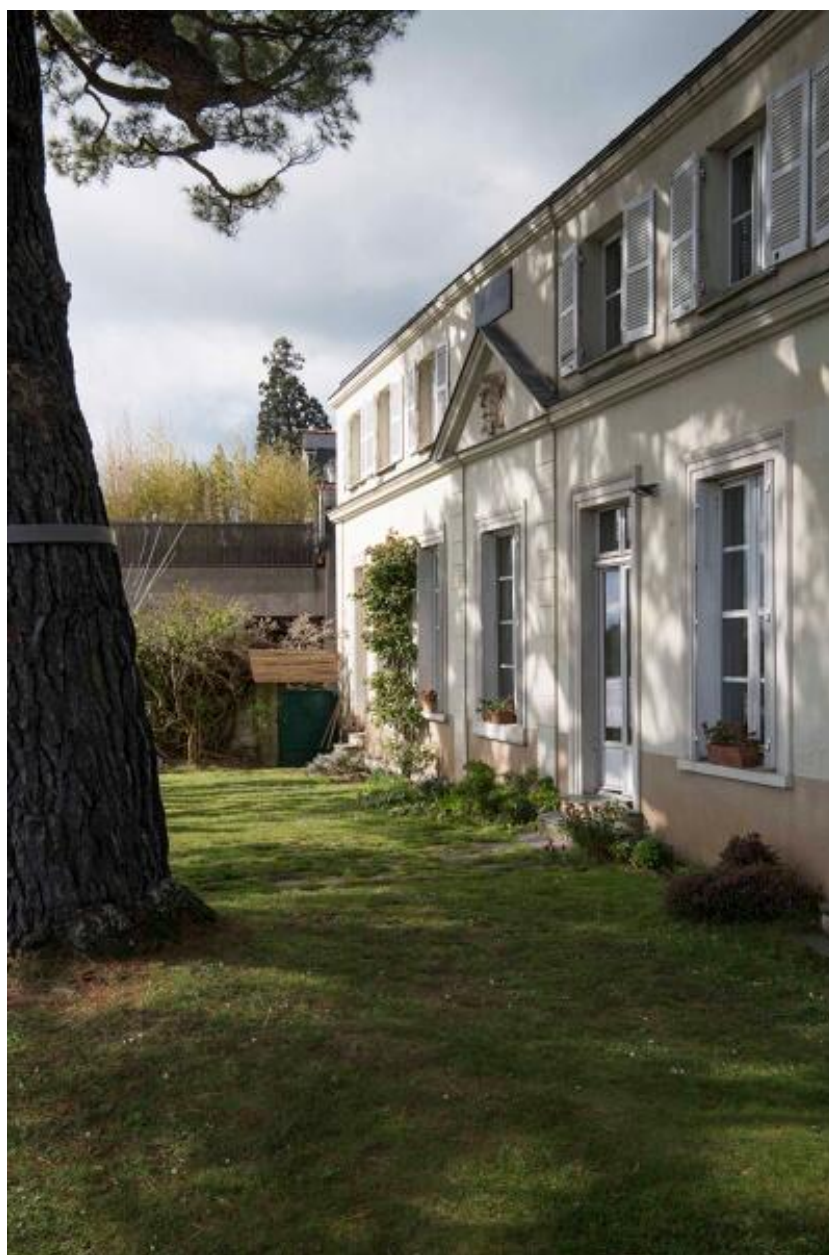
La villa Saint-Paul. Vue de la façade sur Loire depuis le nord-est.
