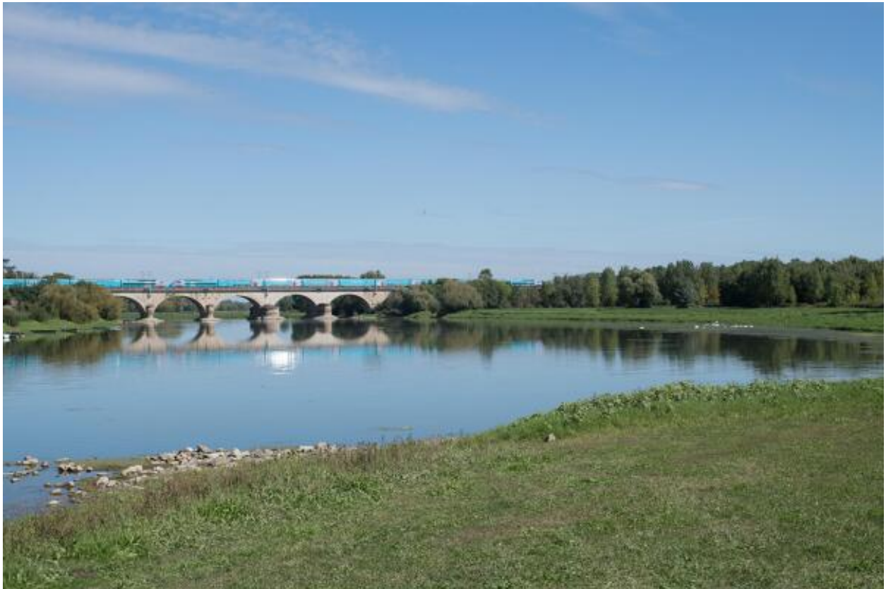
Vue du pont ferroviaire depuis le sud.
