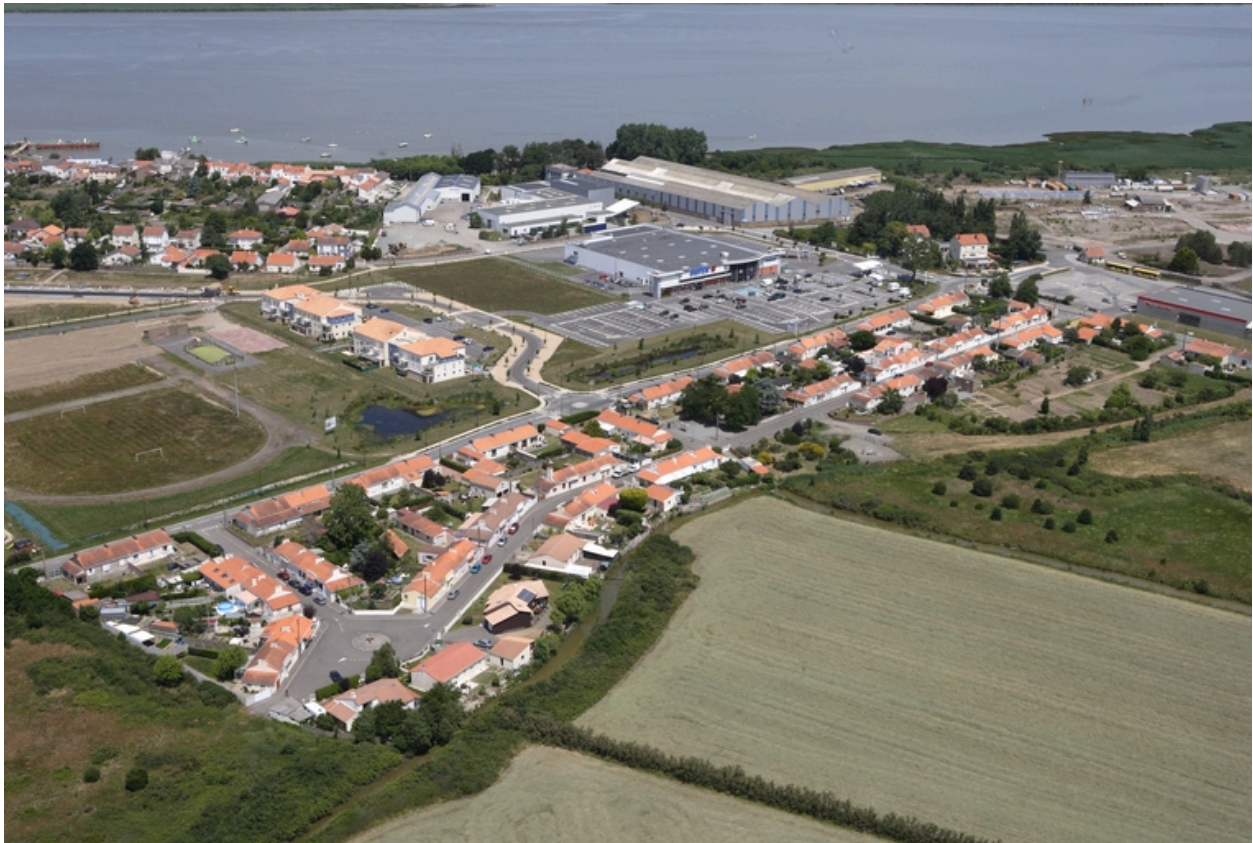
Vue aérienne de la cité des Floralties, à droite le site de l'usine détruite.
