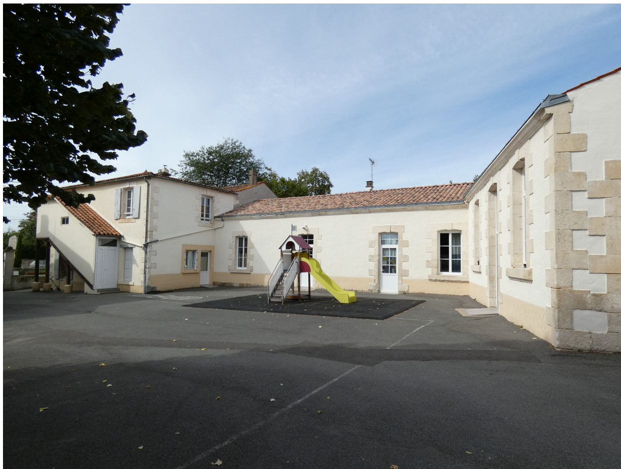
L'ancienne mairie à gauche et les deux bâtiments de classes vus depuis l'est.
