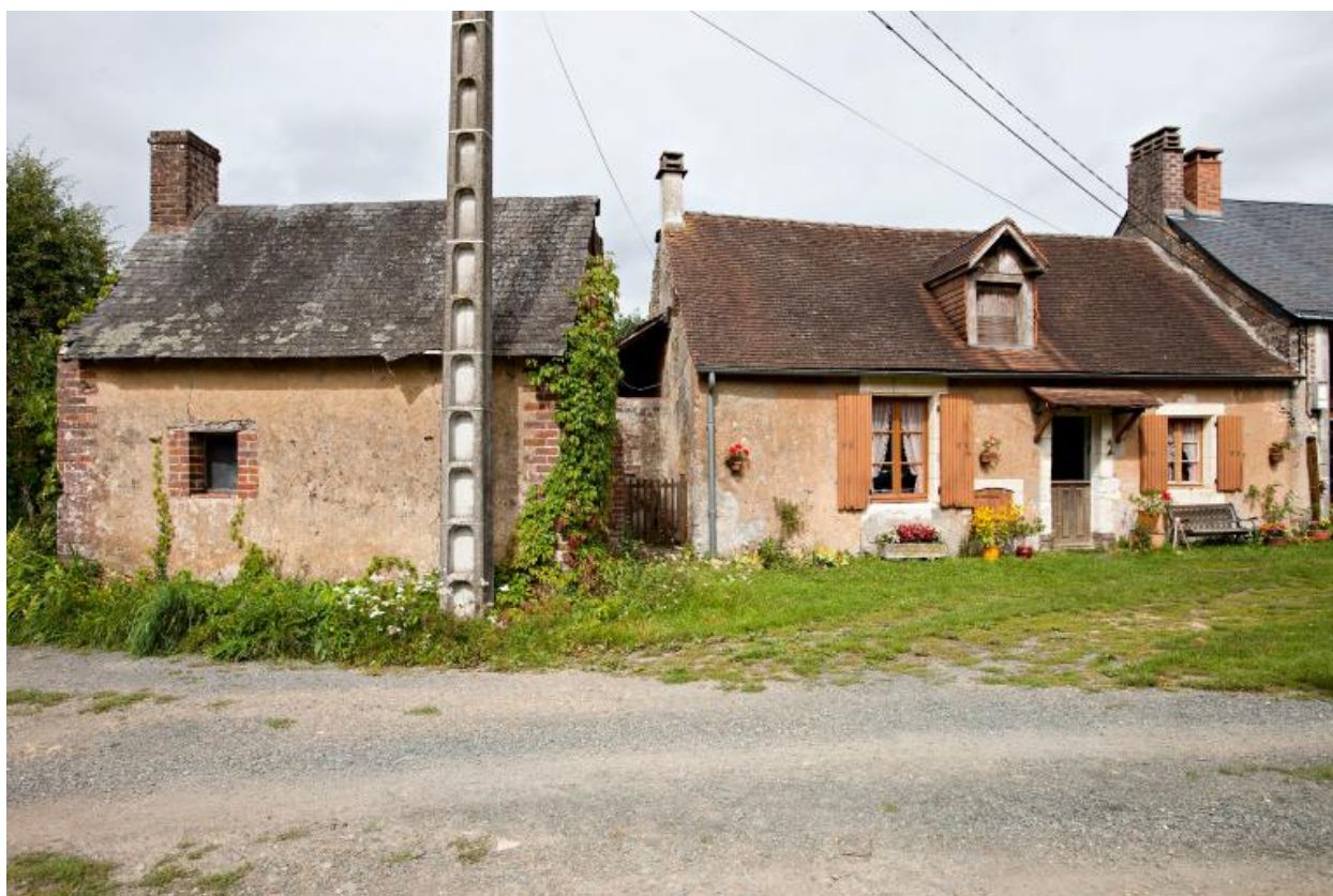
Vue d'ensemble de la buanderie et de la maison.
