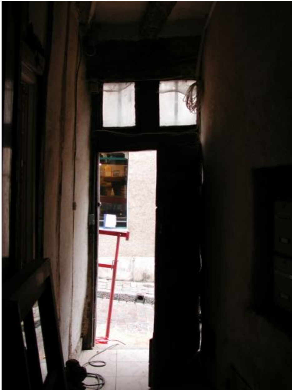
Couloir, vu depuis l'escalier vers la rue, pendant les travaux octobre 2002.
