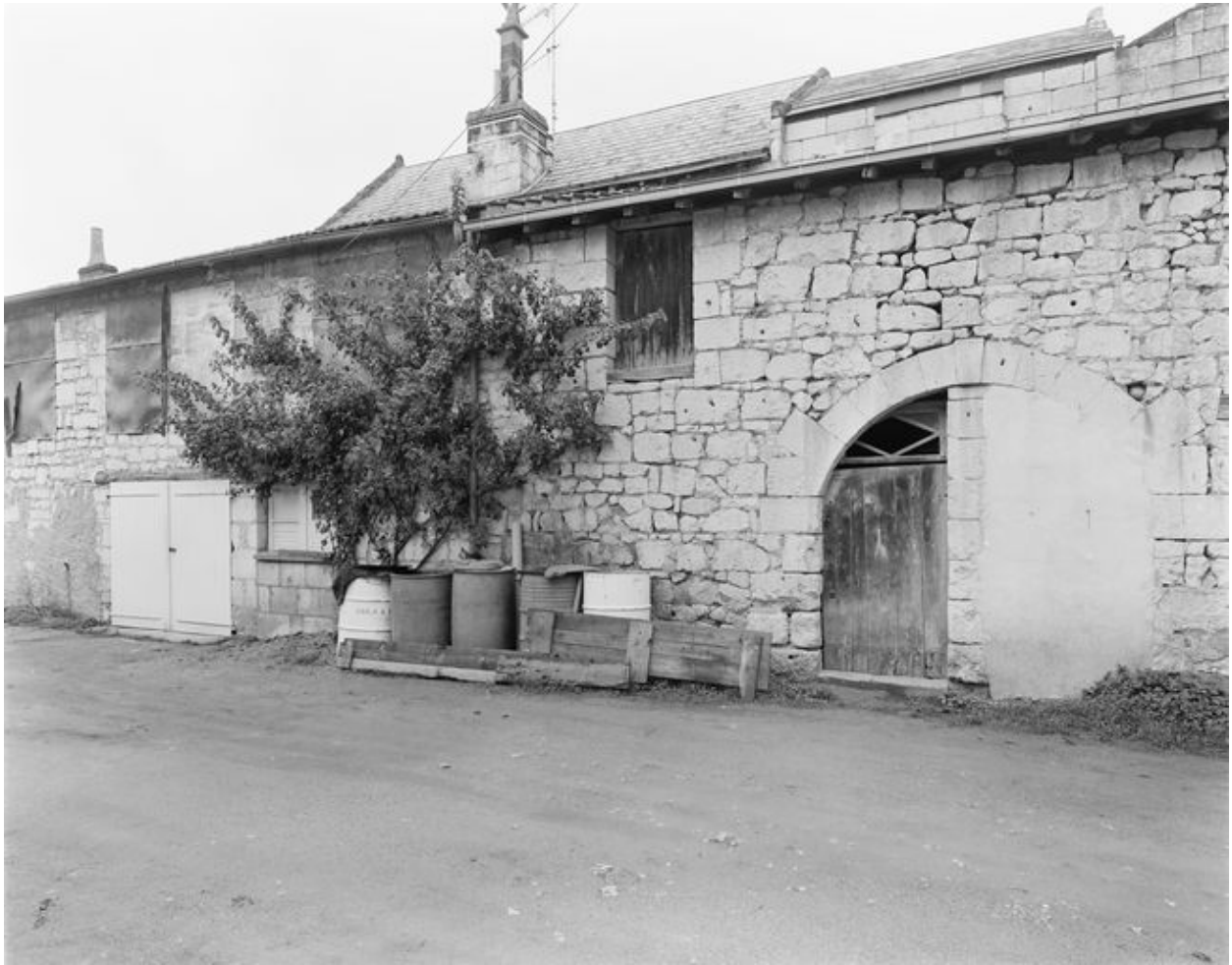
Dépendances sur cour, aile est (état 1996).
