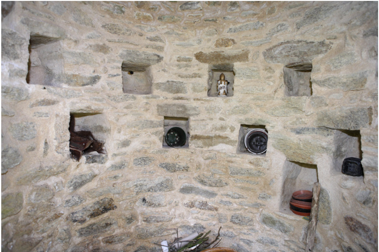
Détail des boulins de la tour nord-ouest.
