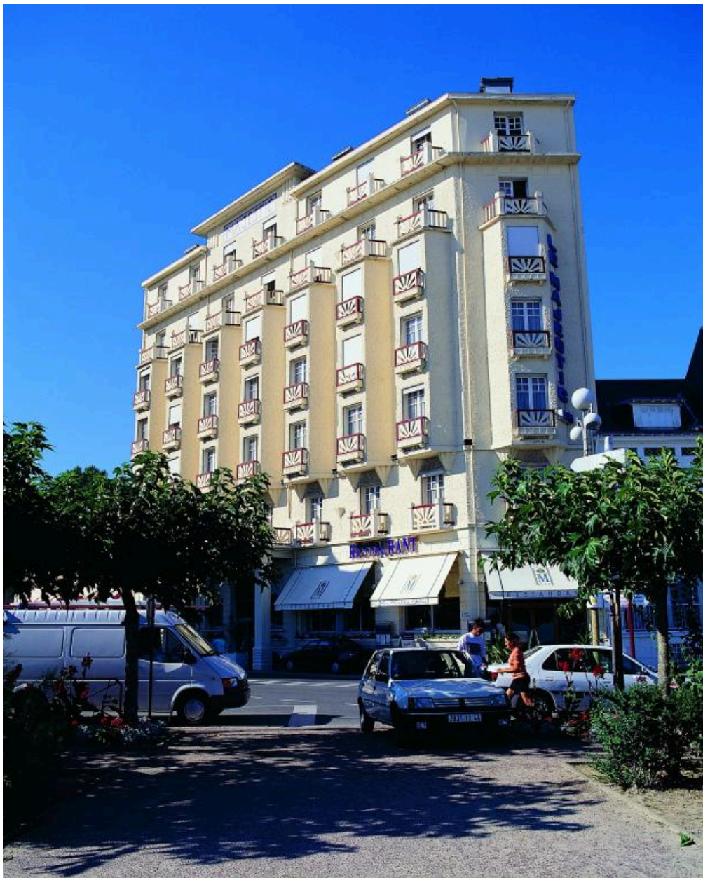
Vue de la façade donnant sur l'avenue de la Noue.
