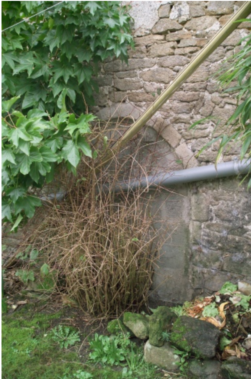
Façade postérieure, détail d'une porte condamnée.
