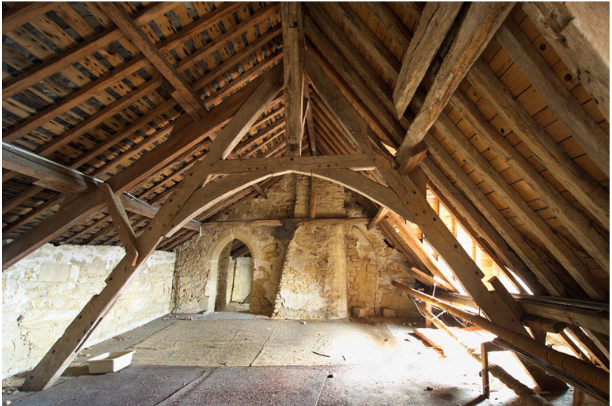
Ferme à aisseliers courbes au-dessus de la grande pièce du logis.
