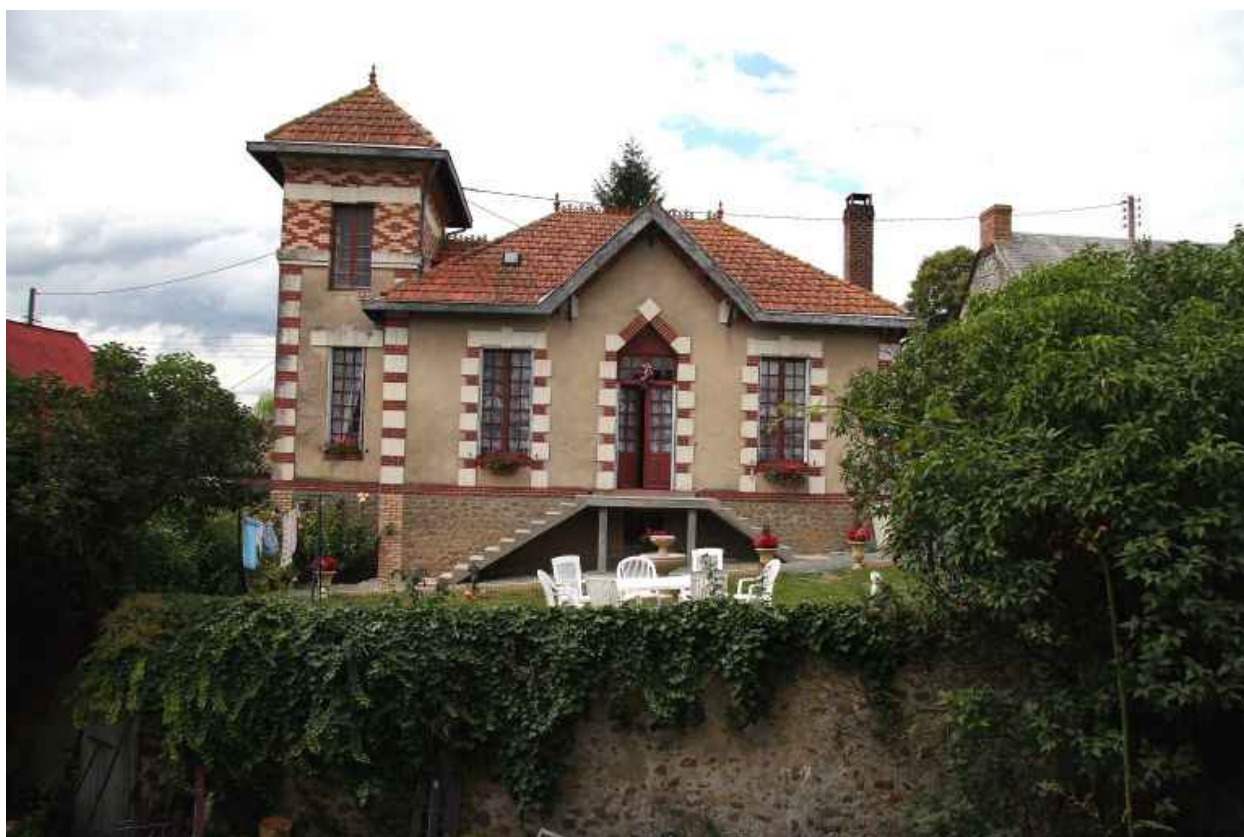
Façade postérieure sur cour.
