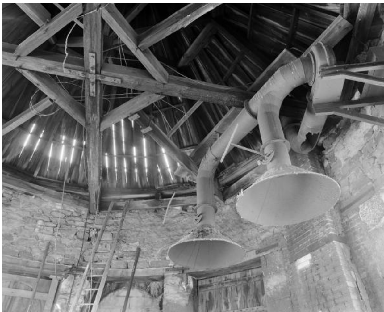
Vue de la charpente et du système d'évacuation des fumées.
