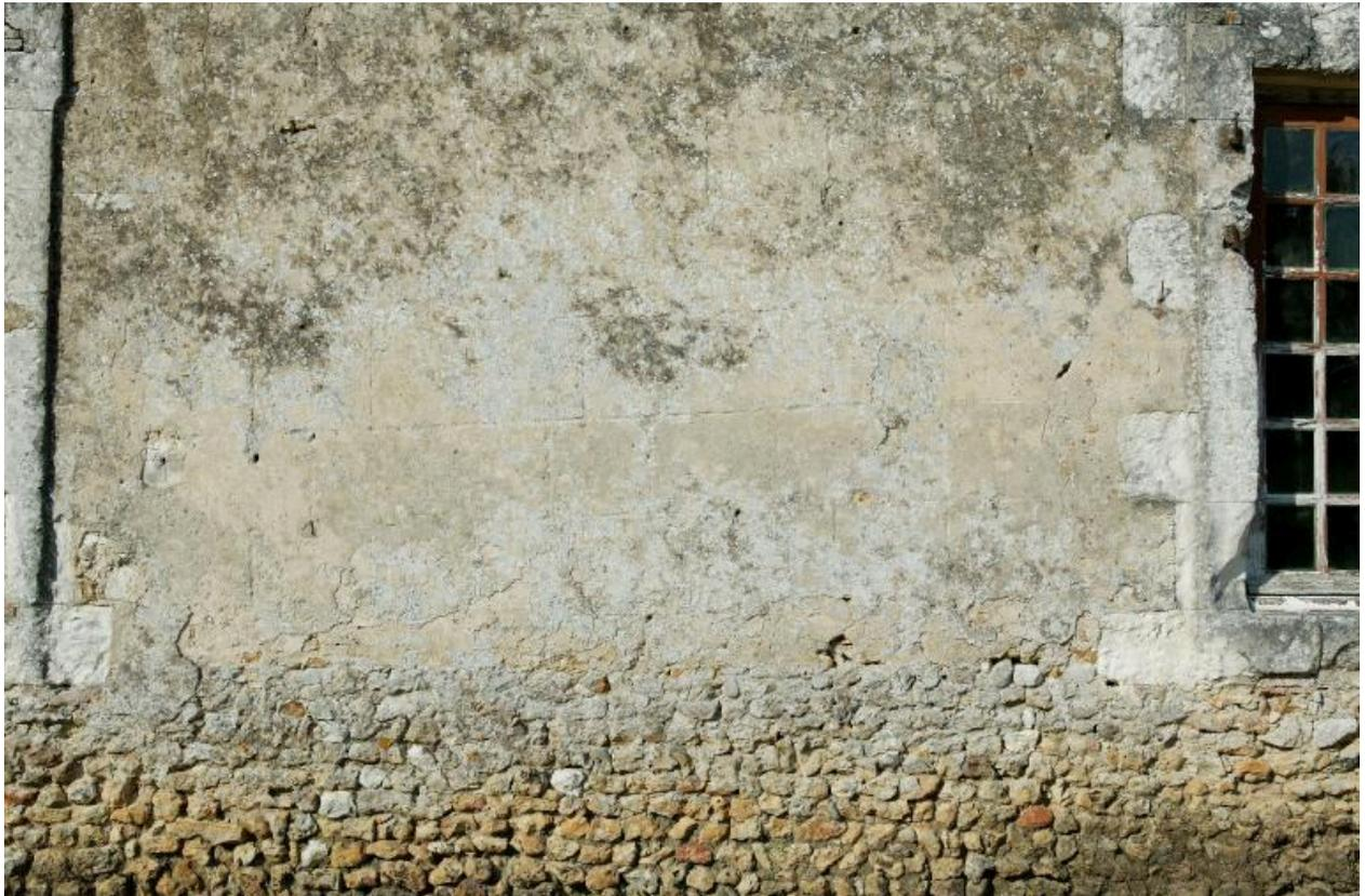
Pavillon nord-ouest, façade ouest : détail des enduits recouvrant les moellons de la maçonnerie et du décor de faux-appareil incisé.
