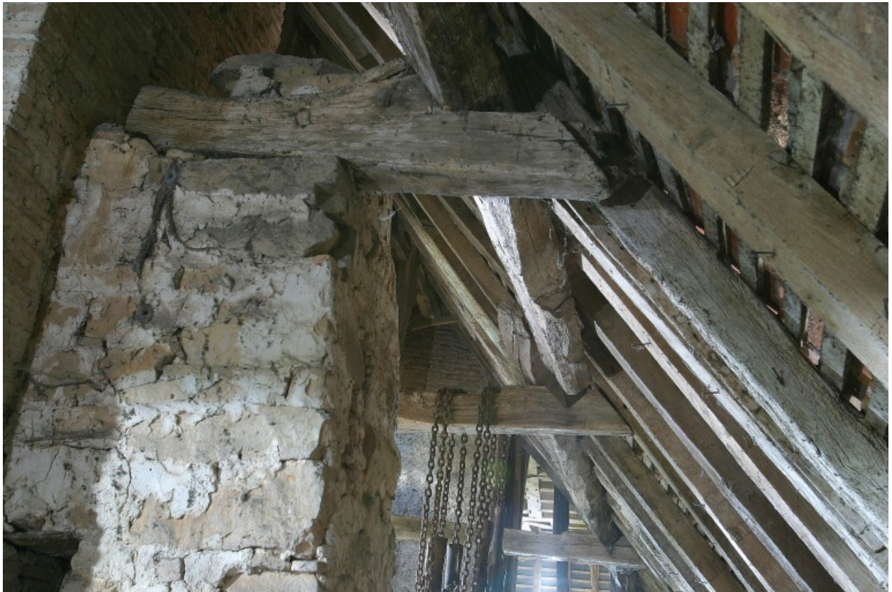
Comble du corps principal. Détail de la charpente vu depuis le nord : panne ouest, entrants retroussés de la ferme centrale et des deuxième et première fermes sud.
