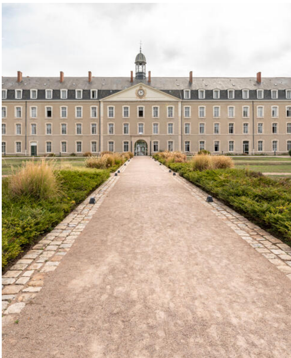
Vue du corps central de la caserne depuis l'allée.
