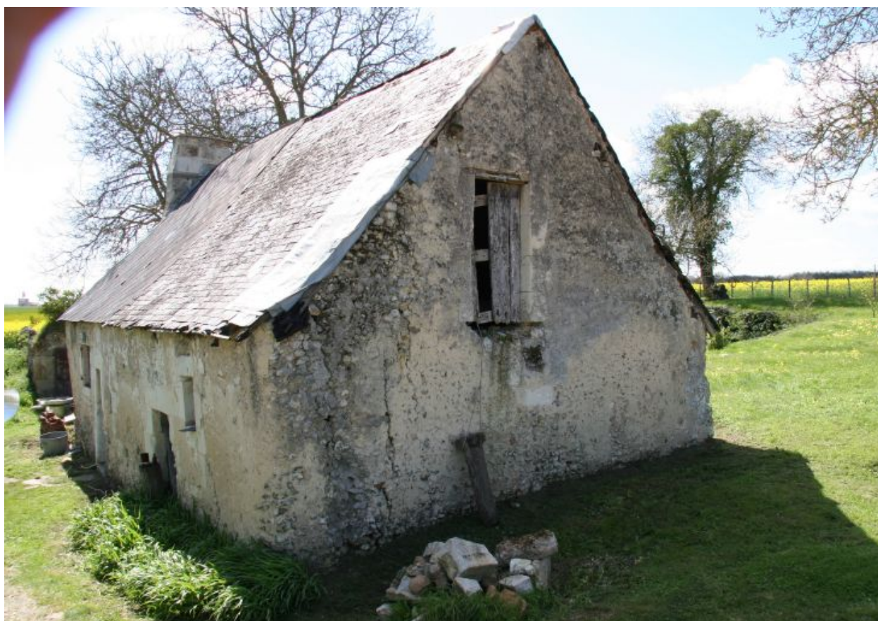
Maison 1, vue de volume prise du nord-est : porte du grenier dans le pignon.
