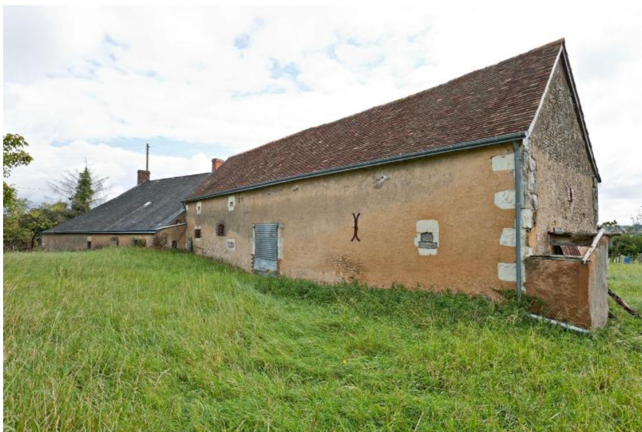
Vue de volume de la grange-étable avec façade postérieure.
