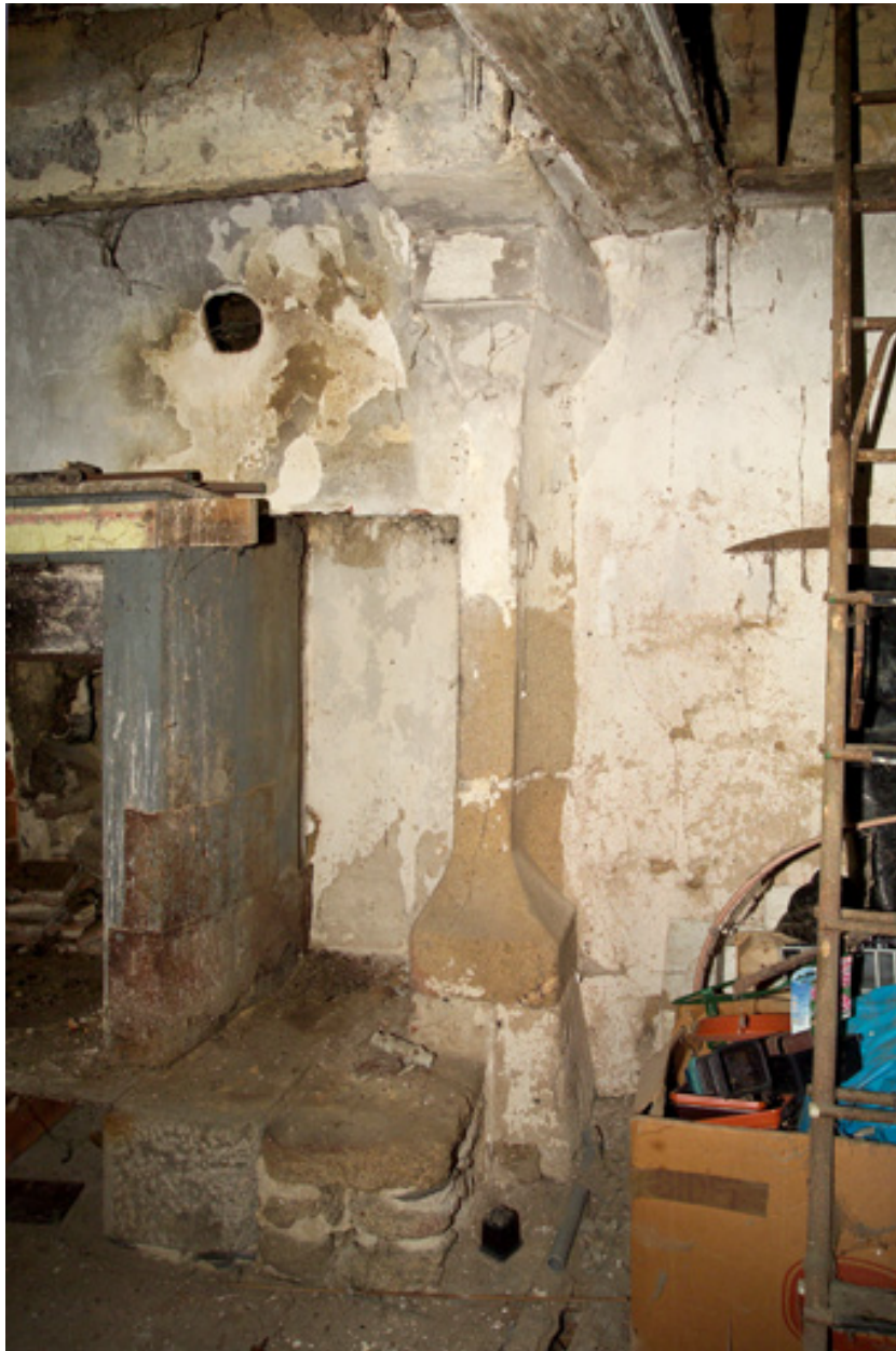
Corps de dépendances oriental, cheminée, détail du montant droit.
