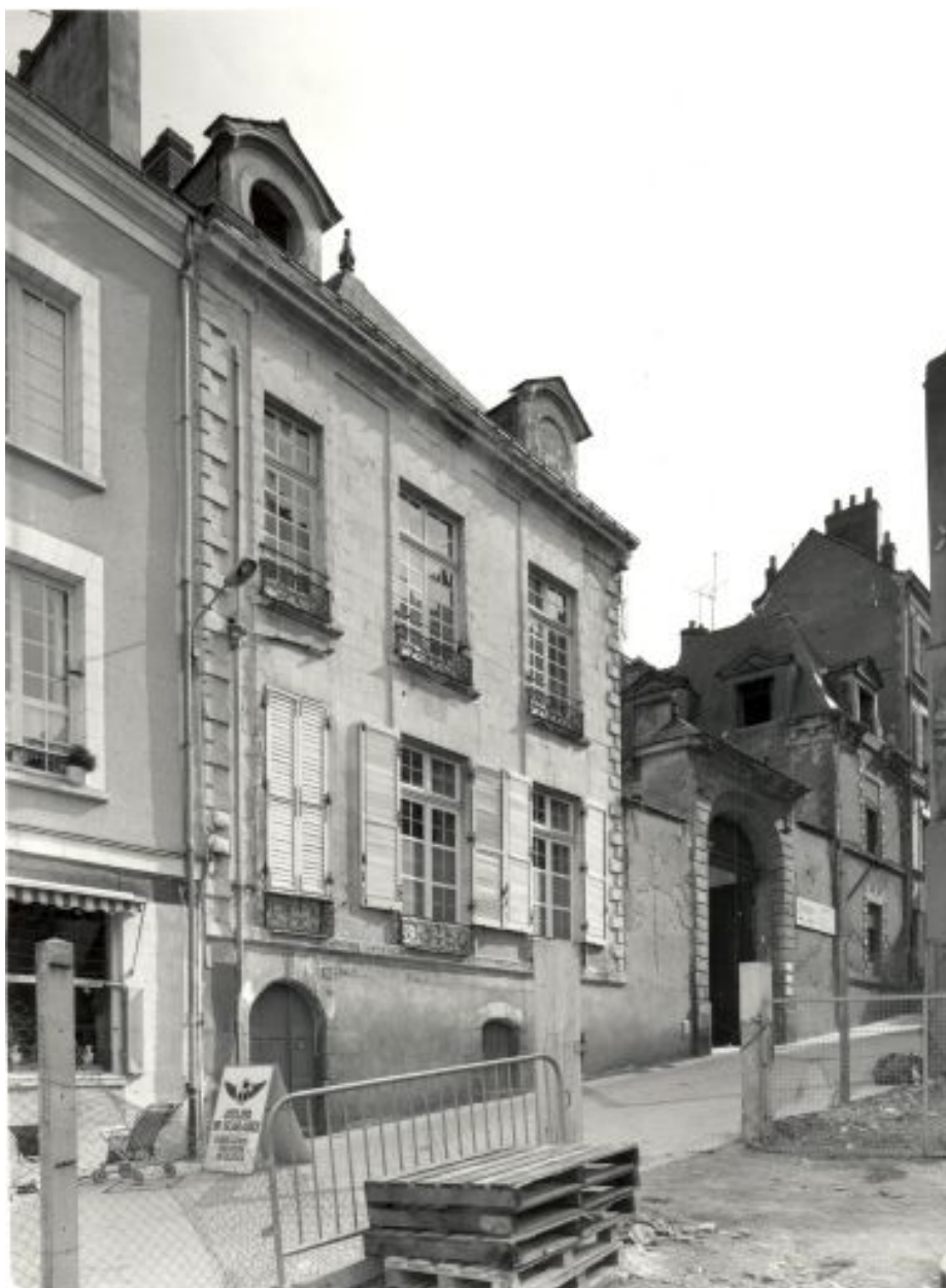
Vue de situation sur la rue, avec le logis au 1er plan.
