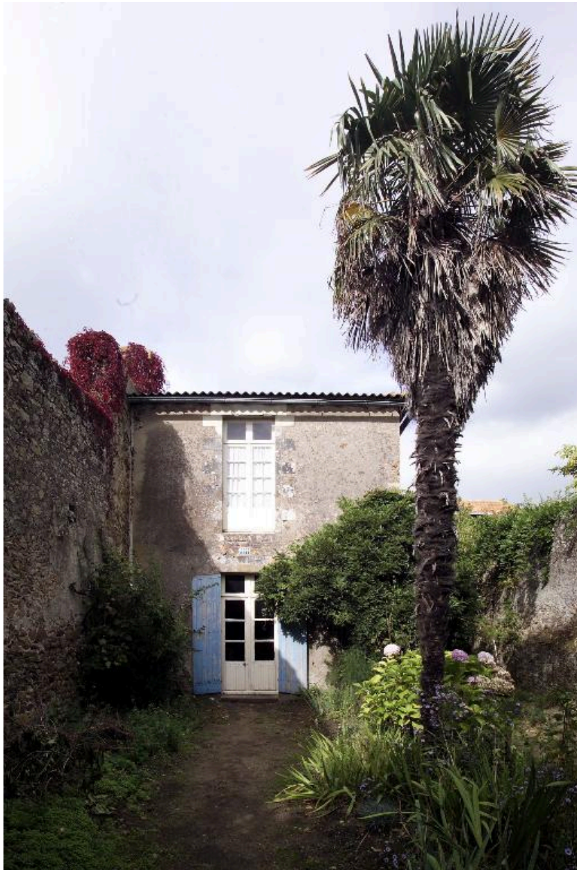
Le pignon sud du corps secondaire : le cellier surélevé.
