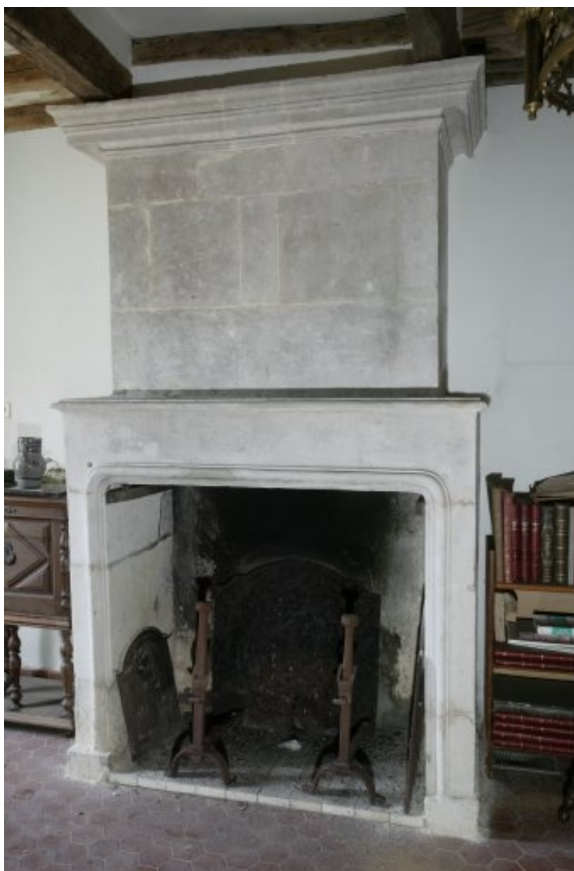
Cheminée à l'étage du bâtiment sud.
