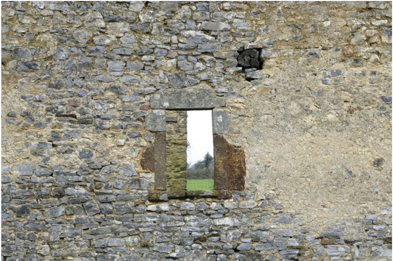
Le logis manorial, détail de l'élévation postérieure : la fenêtre de la partie sud..
