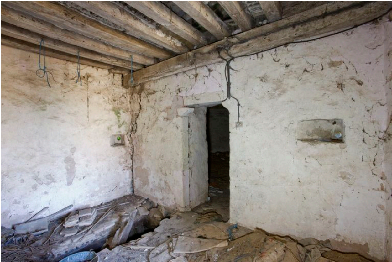
Porte de l'étage carré de la tour, menant vers l'étage du corps principal. A droite de la porte, embrasure intérieure de la meurtrière sud.
