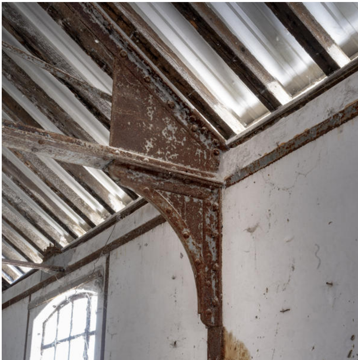
Détail de la charpente du bâtiment F de l'usine de papeterie.
