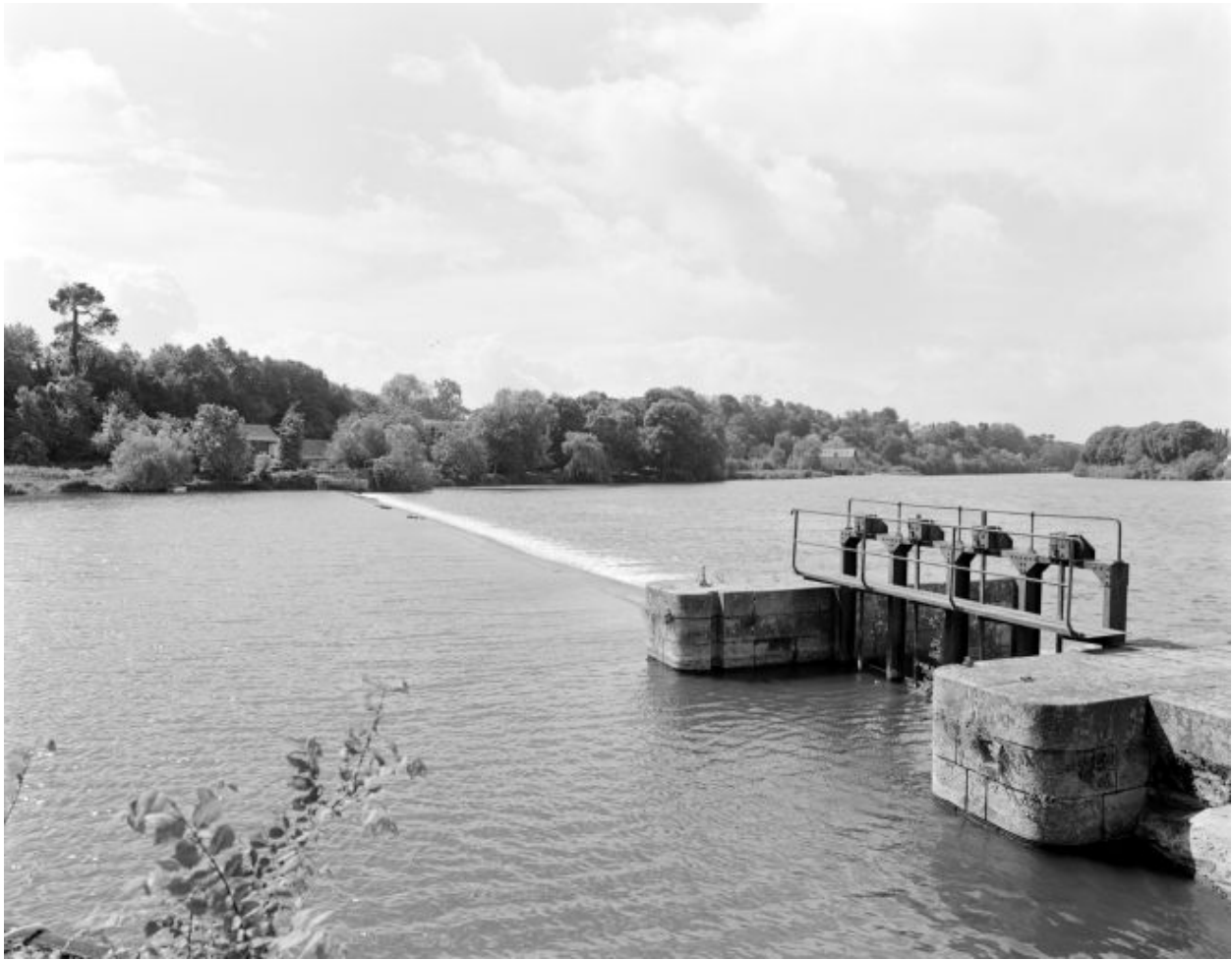
Vue d'ensemble du barrage de la Roche. Au premier plan, le pertuis. Au fond, les vestiges du moulin et ses anciennes dépendances. A droite, le moulin du Gué.
