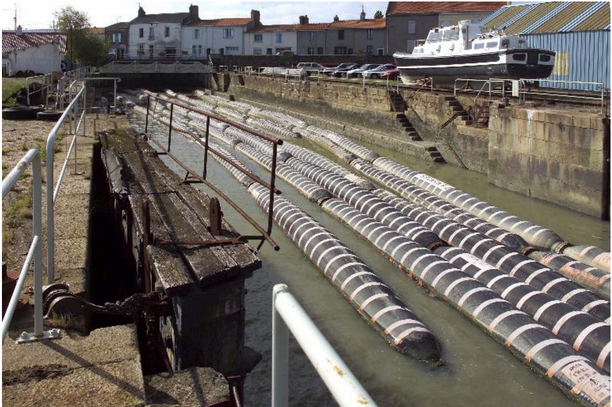
Le bassin de carénage, vue prise vers le quai Chassagne.
