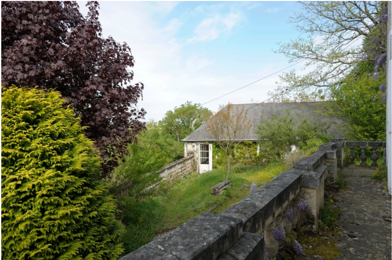
Dépendances nord, vues depuis la terrasse du logis.
