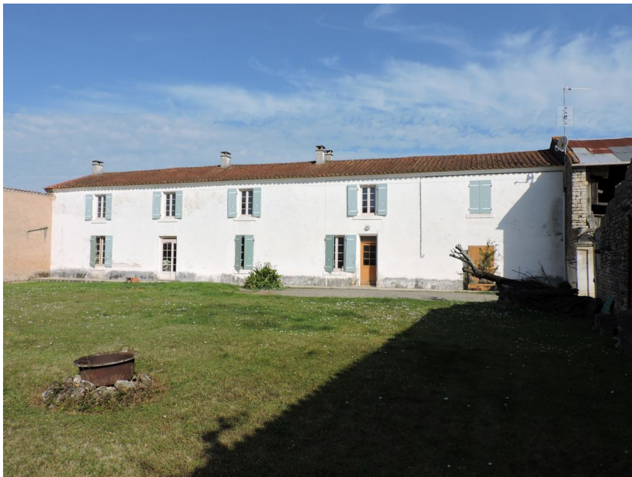
Le logis et la grange-étable qui le prolonge à droite, vus depuis le sud-est.
