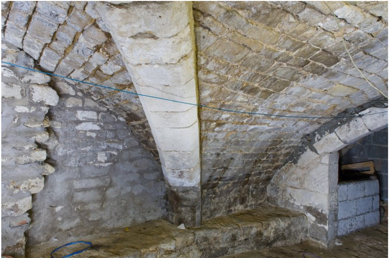
Sous-sol de la maison 4, place du Commerce : vue prise du nord avec, à droite, un petit caveau.
