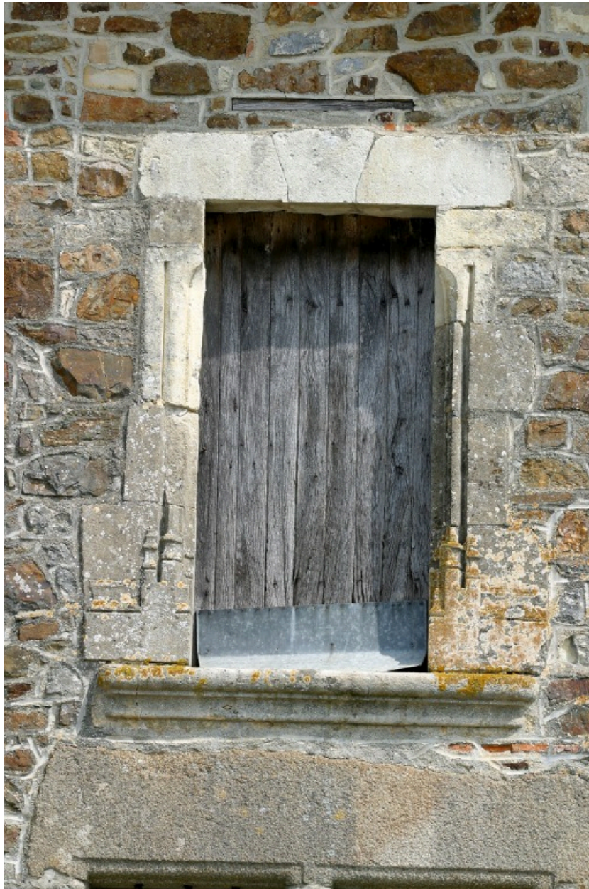
Le logis. Détail de l'élévation principale : la fenêtre gauche de l'étage.
