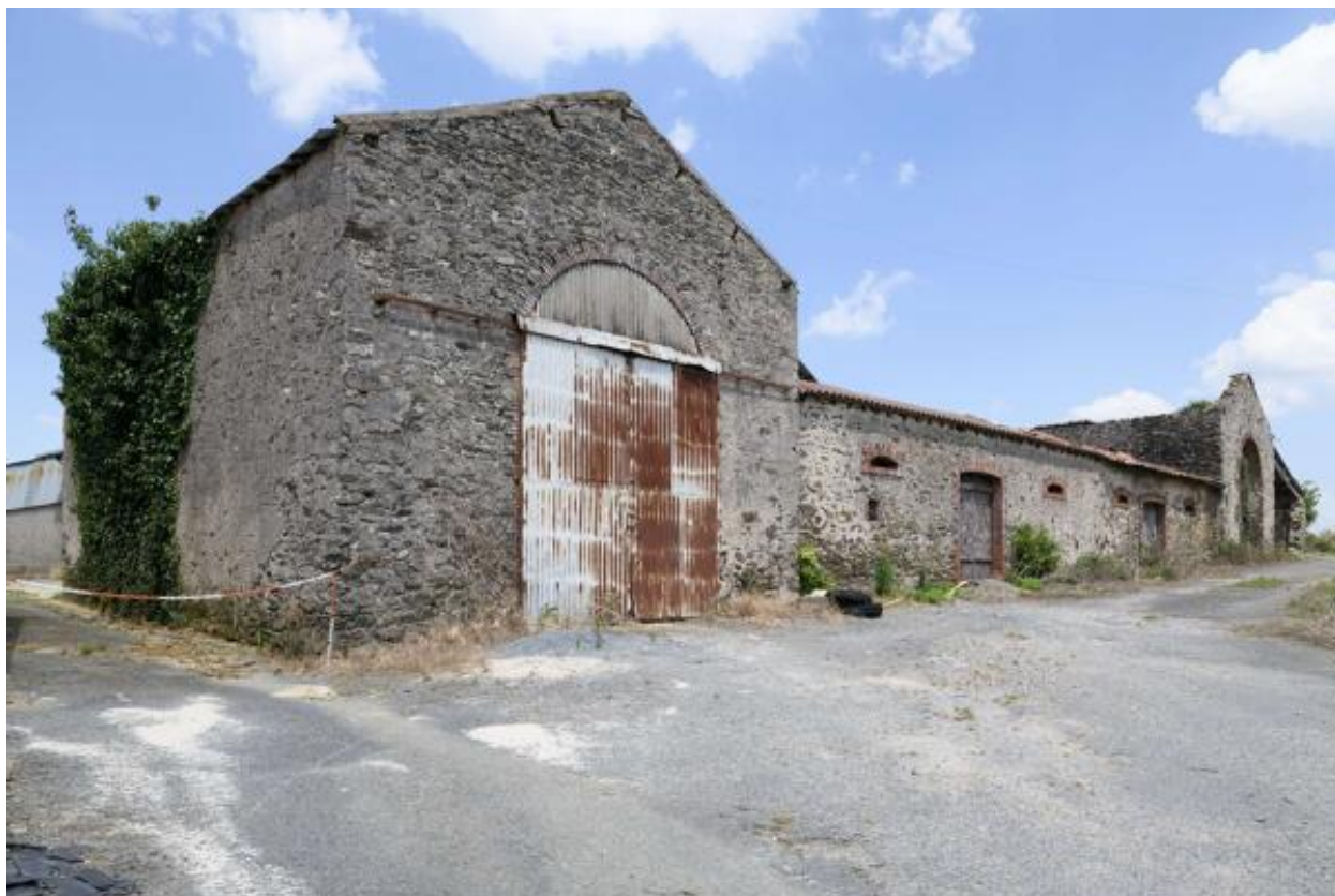
Vue des granges-étables depuis le sud-ouest.
