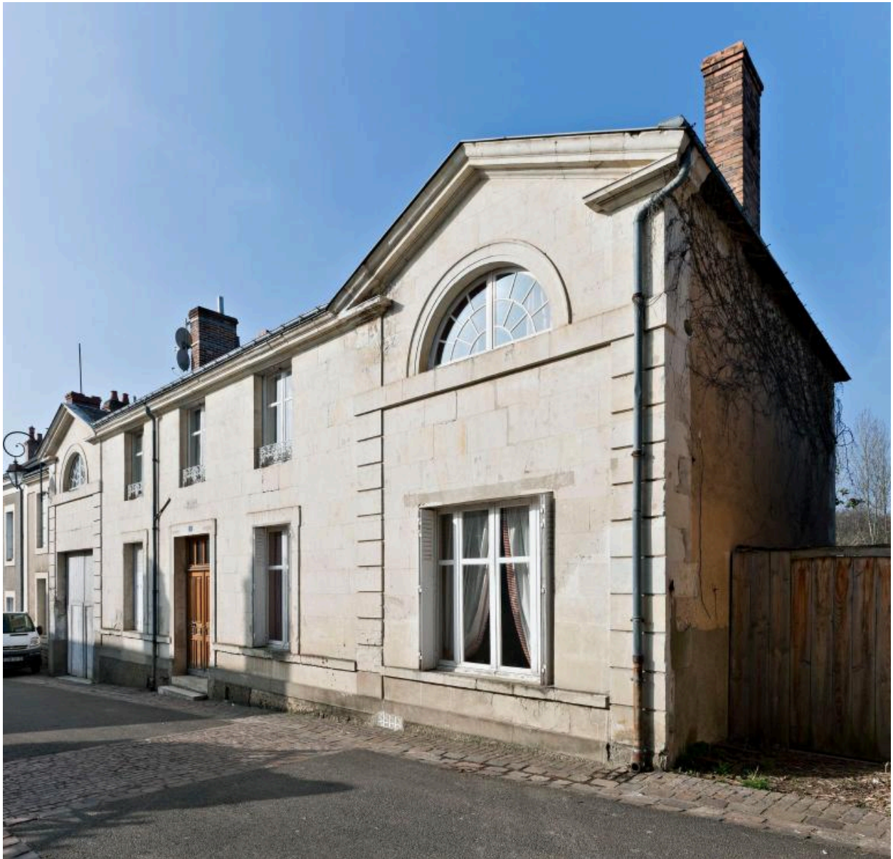
Maison, façade sur rue prise depuis le nord-est.
