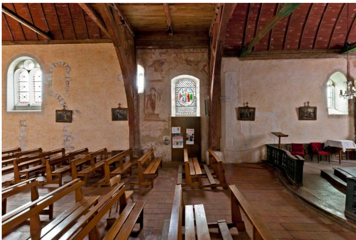
Détail du mur nord de l'église.
