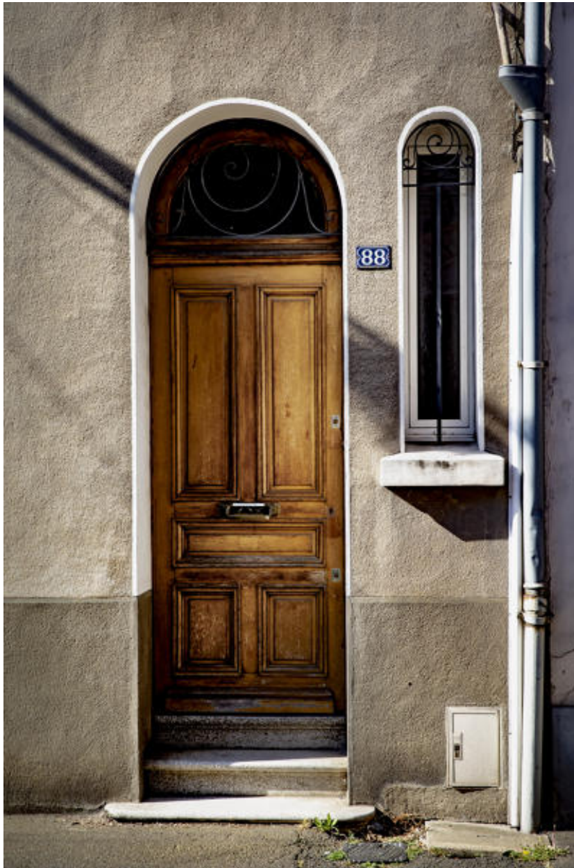
Vue de la travée d'entrée en rez-de-chaussée d'une maison de type années 1930 rue du Pavé.
