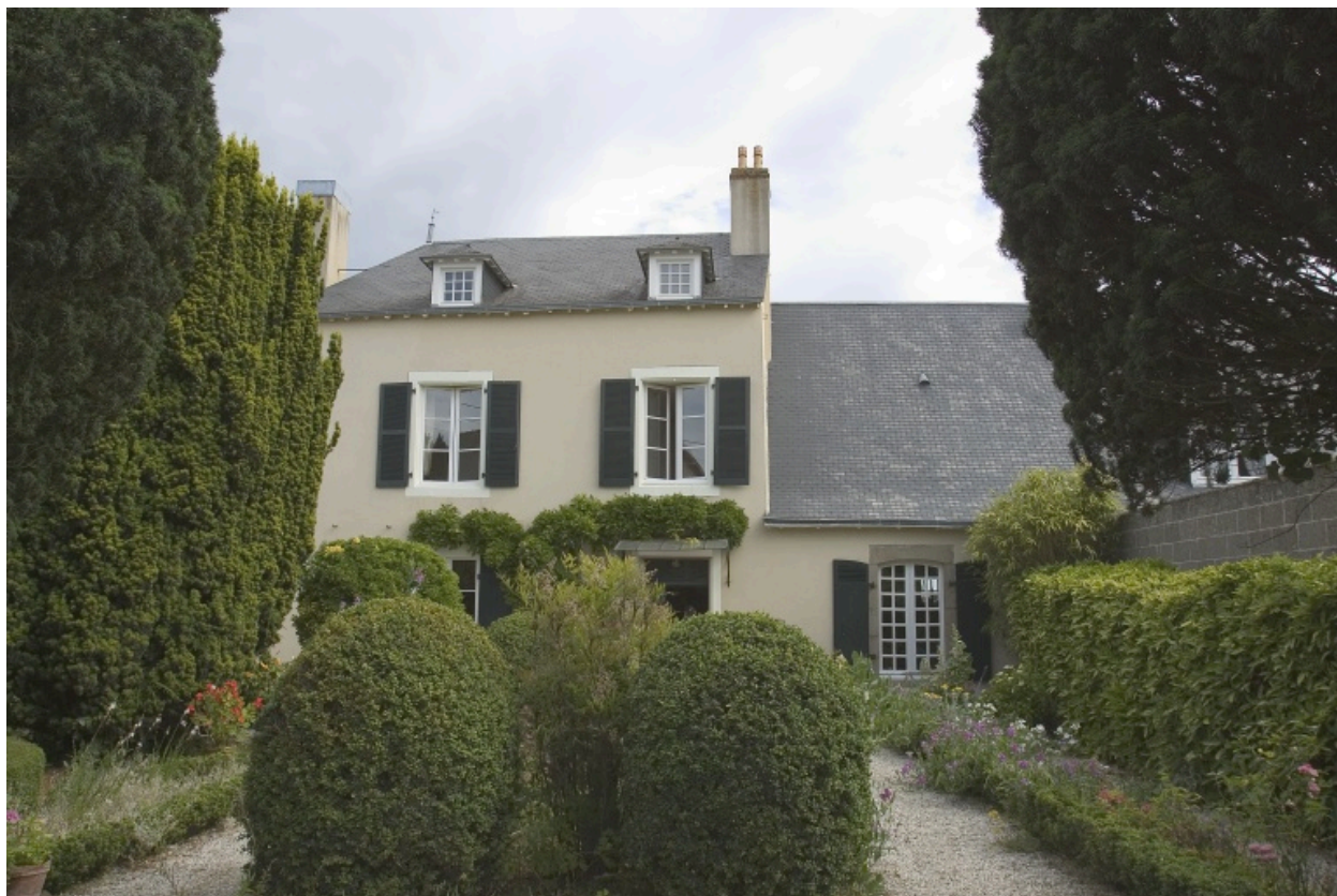
Le bâtiment principal vu depuis la cour au sud.
