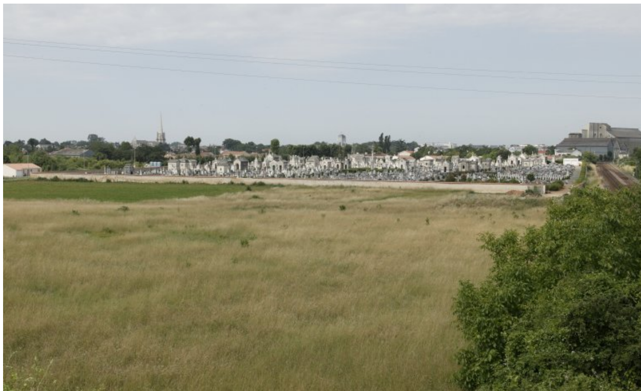
Vue d'ensemble éloignée, prise de l'est.
