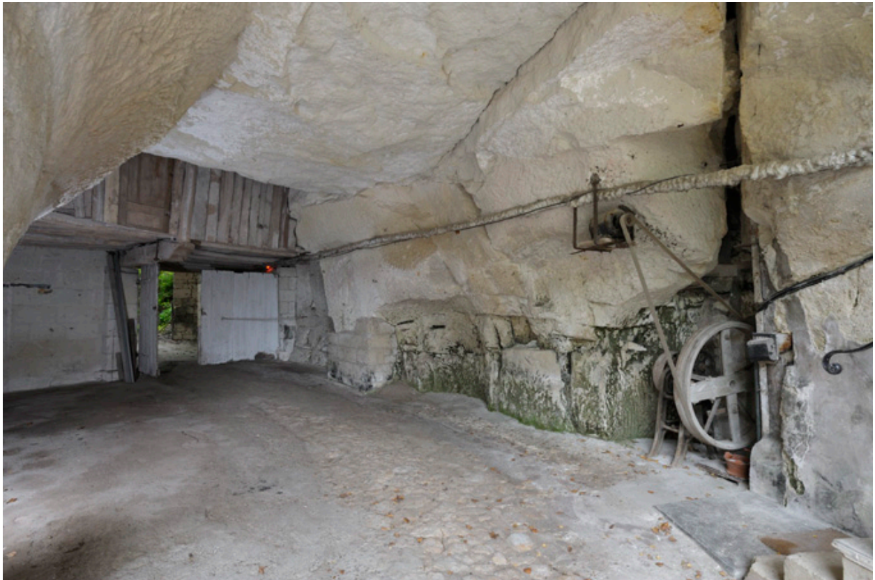
Bouche de cavage formant une première arche, avec puits remplacé par une pompe électrique au XXe siècle.
