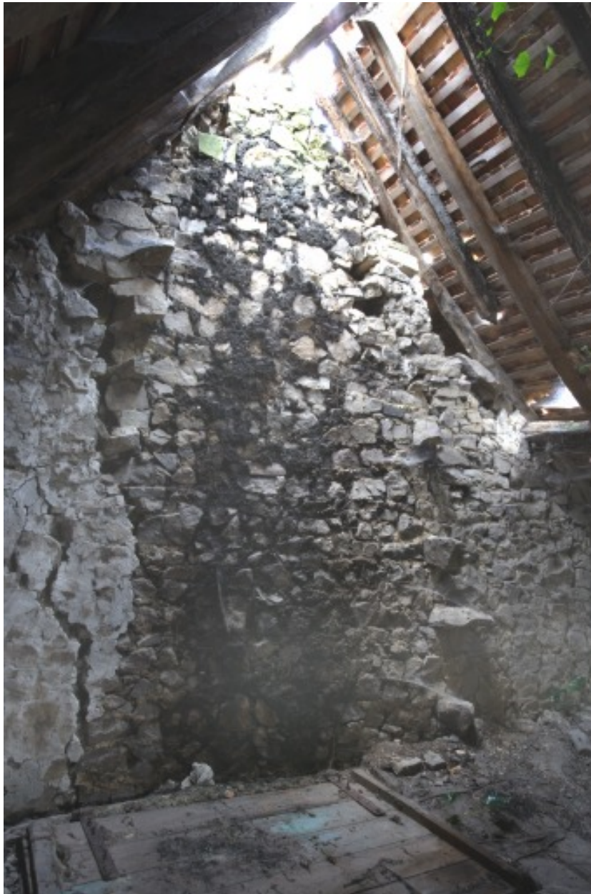
Le logis-étale ouest, comble de la partie logis : la cloison ouest.
